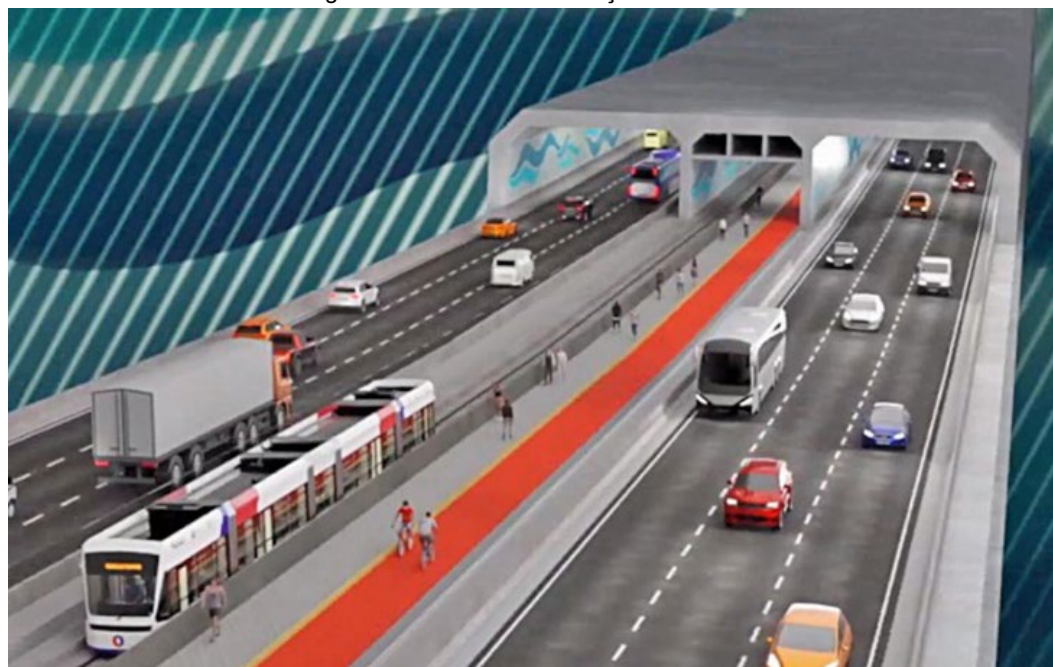
Figura 6 - Túnel Imerso - Seção Conceitual
