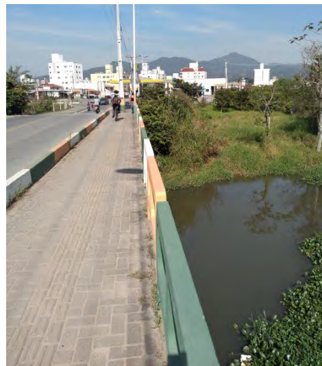
Foto 14: Ponte sobre o rio Camboriú, na Rua Ricardo Assi.
