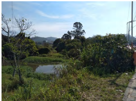
Foto 15: Entorno da ponte sobre o rio Camboriú, na Rua Ricardo Assi.
