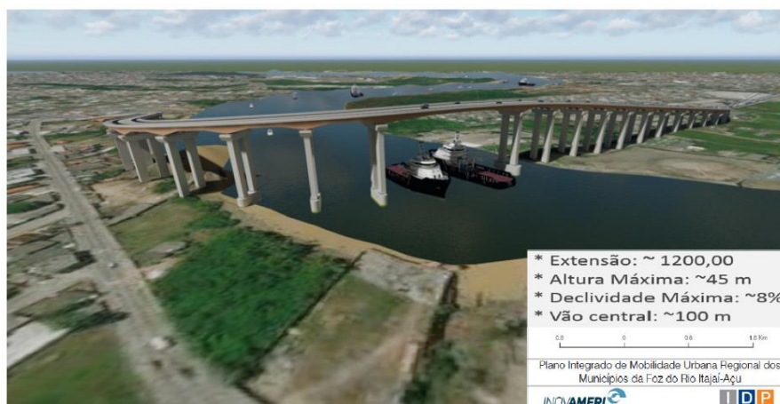
Figura 169 - Perspectiva do Anteprojeto da Ponte Itajaí-Navegantes
