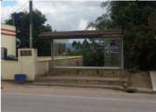
Figura 32 – Parada de ônibus em Ilhota, SC-412 (Rodovia Jorge Lacerda)
