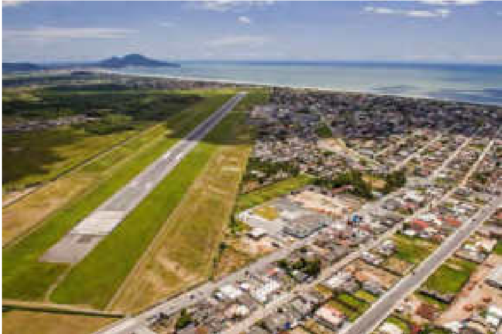
Figura 4 – Instalações do Aeroporto Internacional de Navegantes - Ministro Victor Konder
