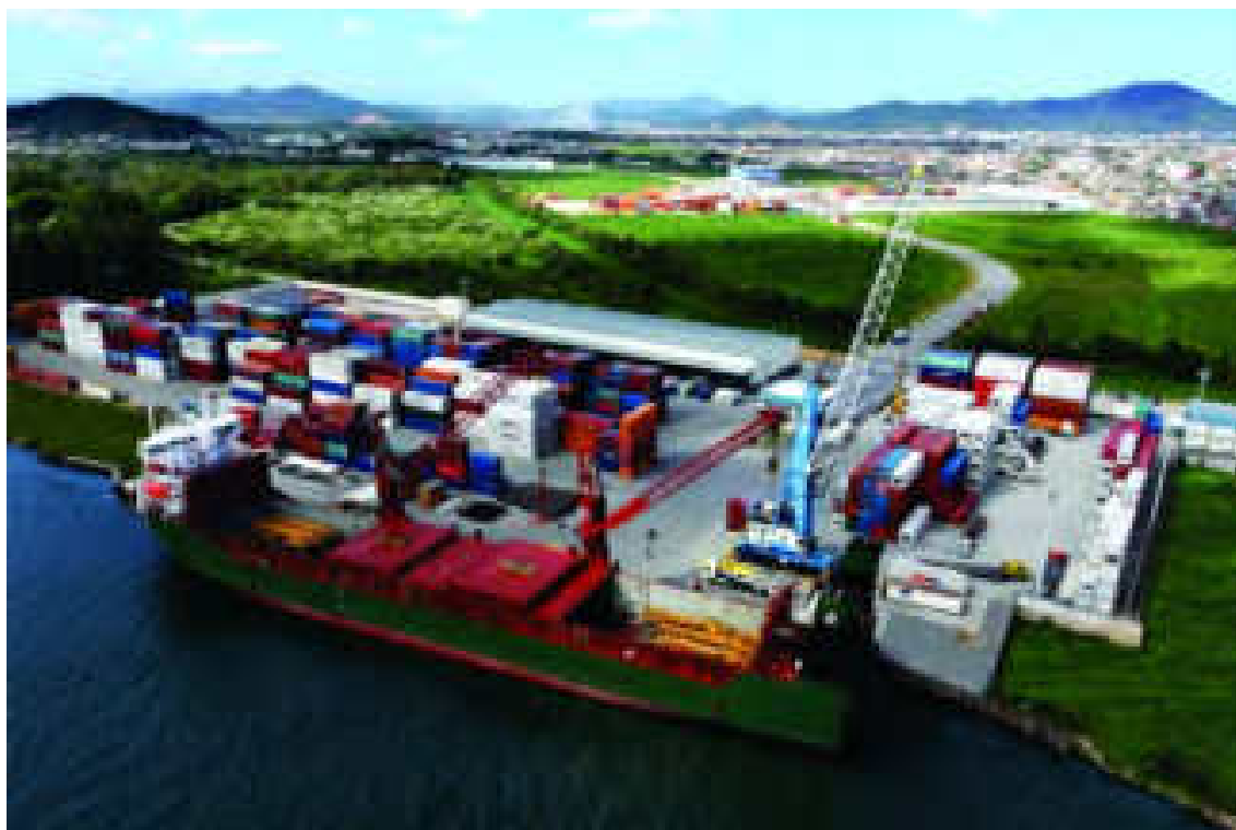
Figura 8 – Instalações do TEPORTI - Terminal Portuário de Itajaí
