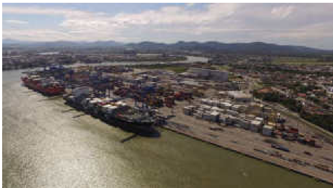
Figura 6 – Instalações da Portonave
