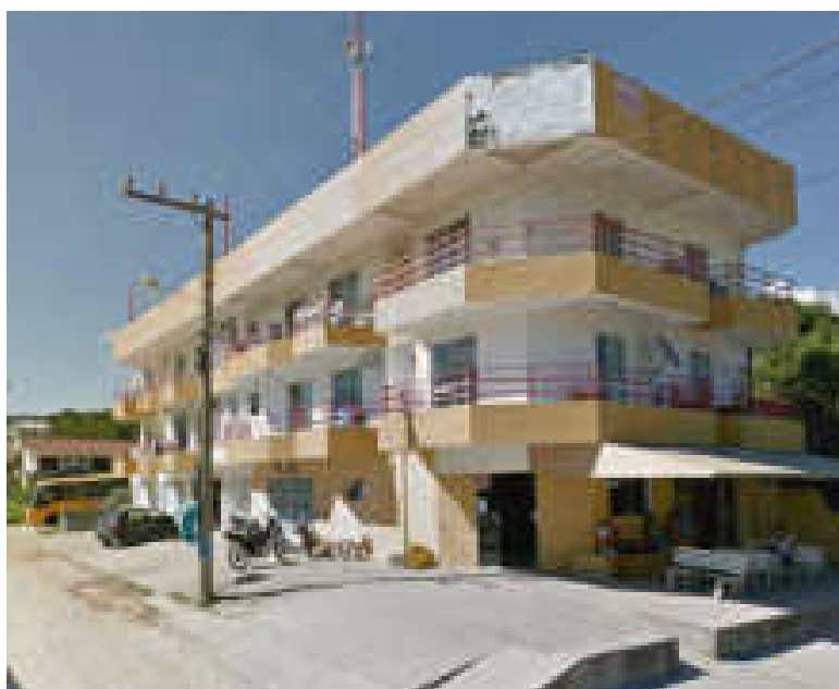
Figura 47 – Terminal Rodoviário e Agência de Passagens Rosa dos Ventos de Porto Belo
