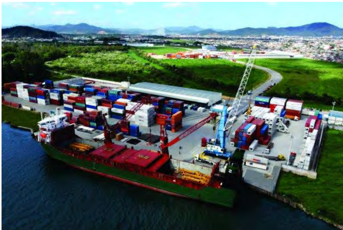
Figura 7 – Instalações do TEPORTI - Terminal Portuário de Itajaí
