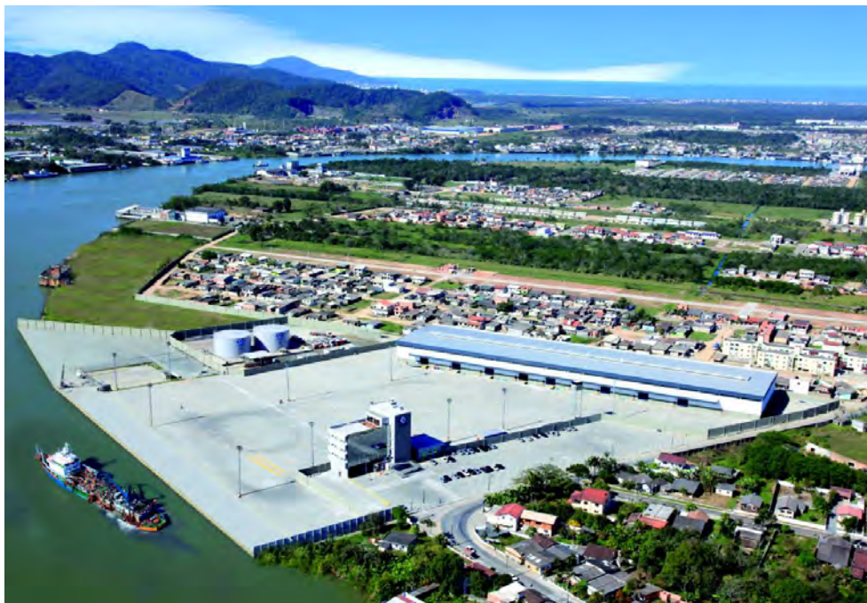
Figura 6 – Instalações da Poly Terminais Portuários
