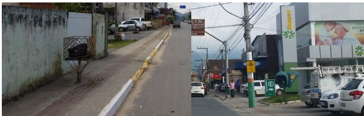
Figura 46 – Mobiliário urbano posicionado de forma incorreta e piso tátil executado incorretamente
