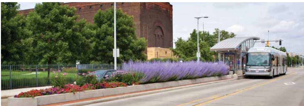
Figura 45 – Corredor Av. Euclid em Cleveland
