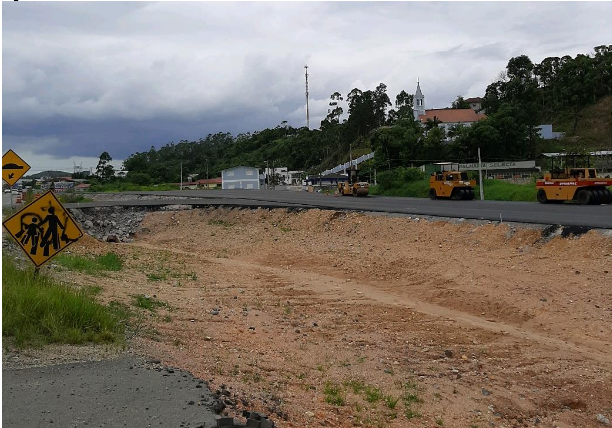
Figura 10: Obras na rodovia SC-486 Antônio Heil.
