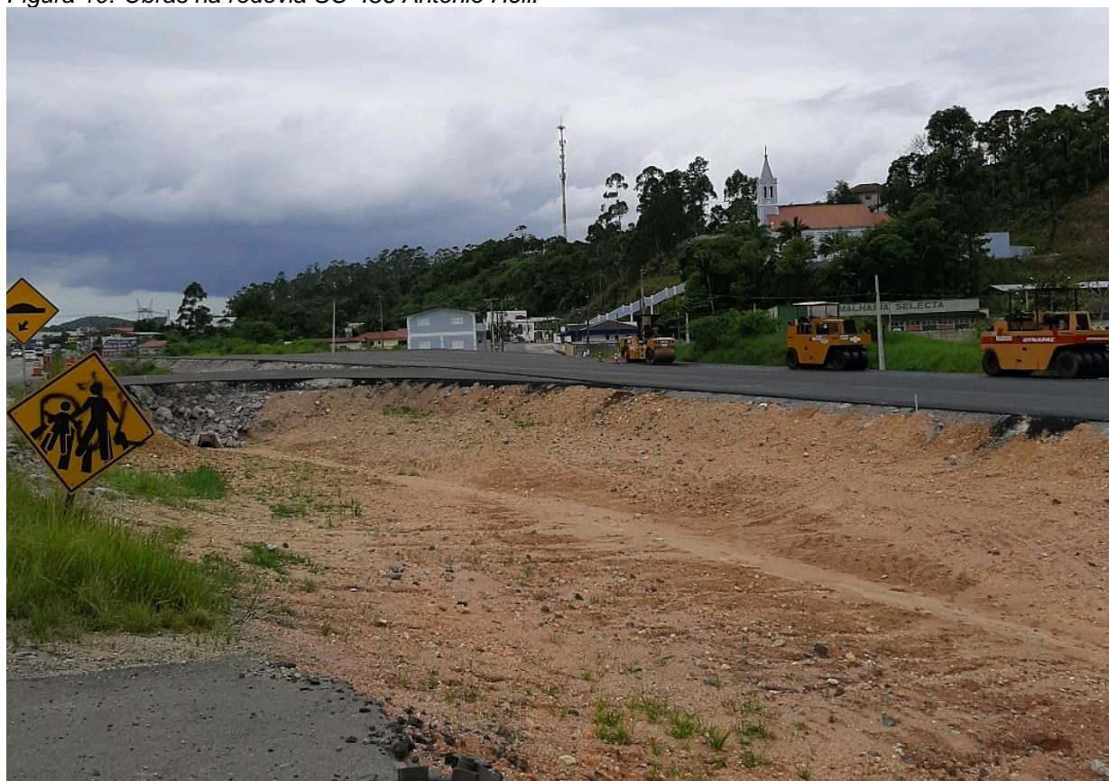
Figura 10: Obras na rodovia SC-486 Antônio Heil.
