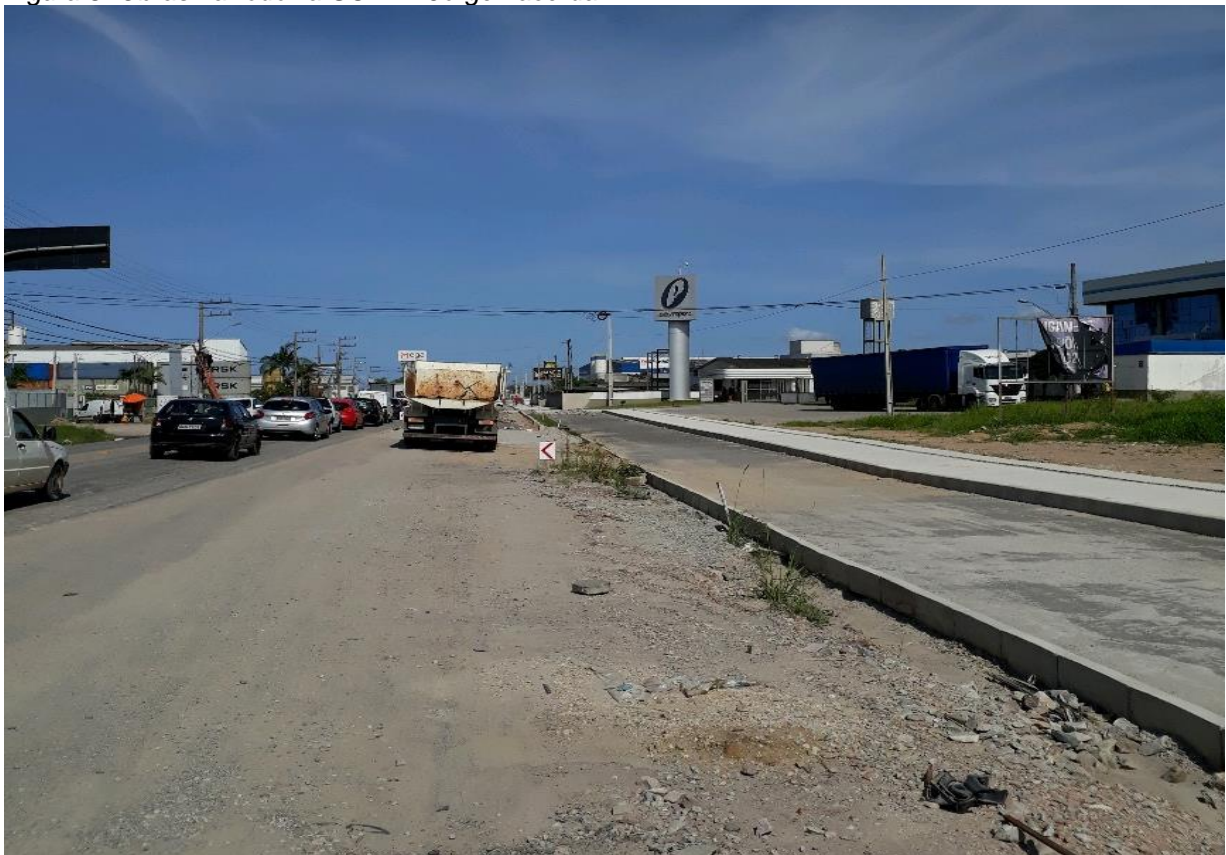
Figura 8: Obras na rodovia SC-412 Jorge Lacerda.
