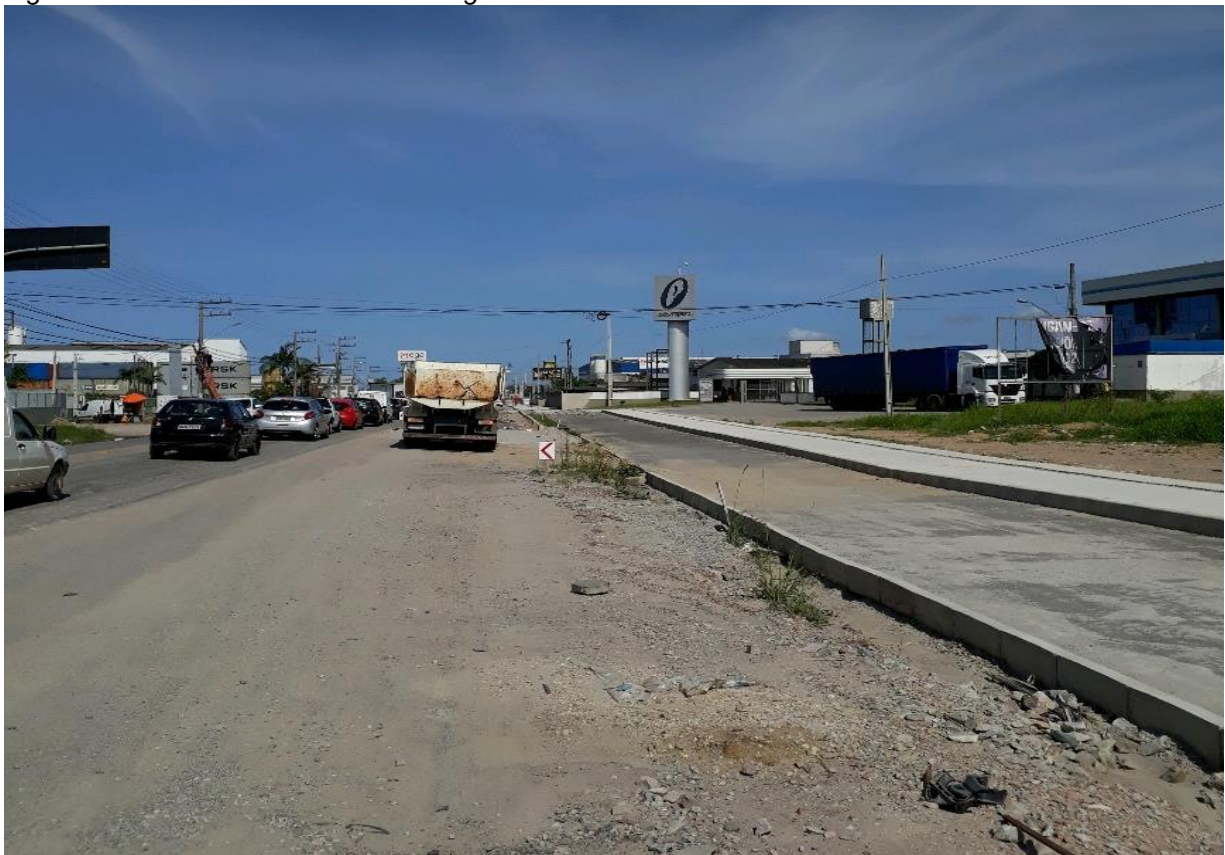
Figura 8: Obras na rodovia SC-412 Jorge Lacerda.
