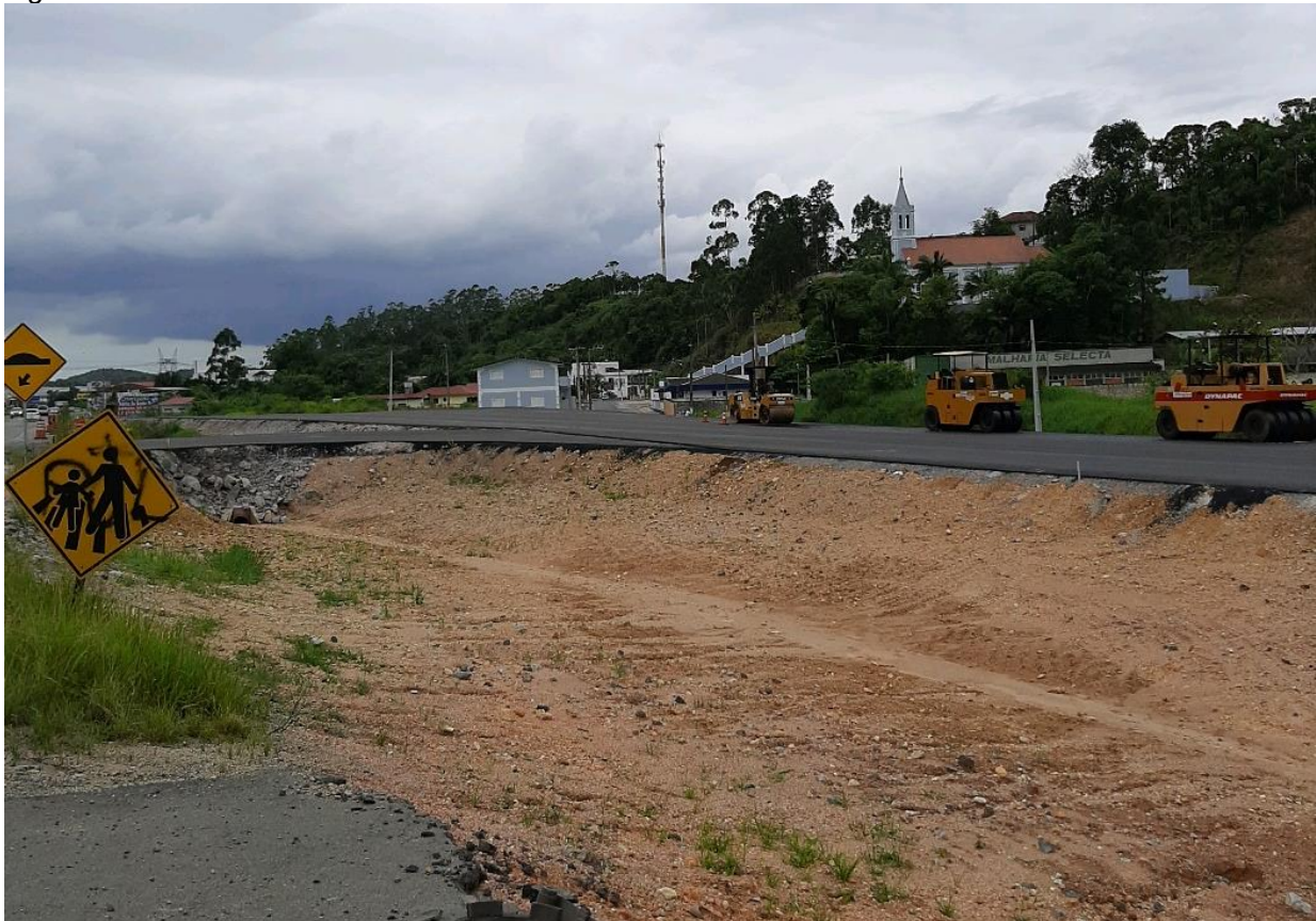
Figura 10: Obras na rodovia SC-486 Antônio Heil.
