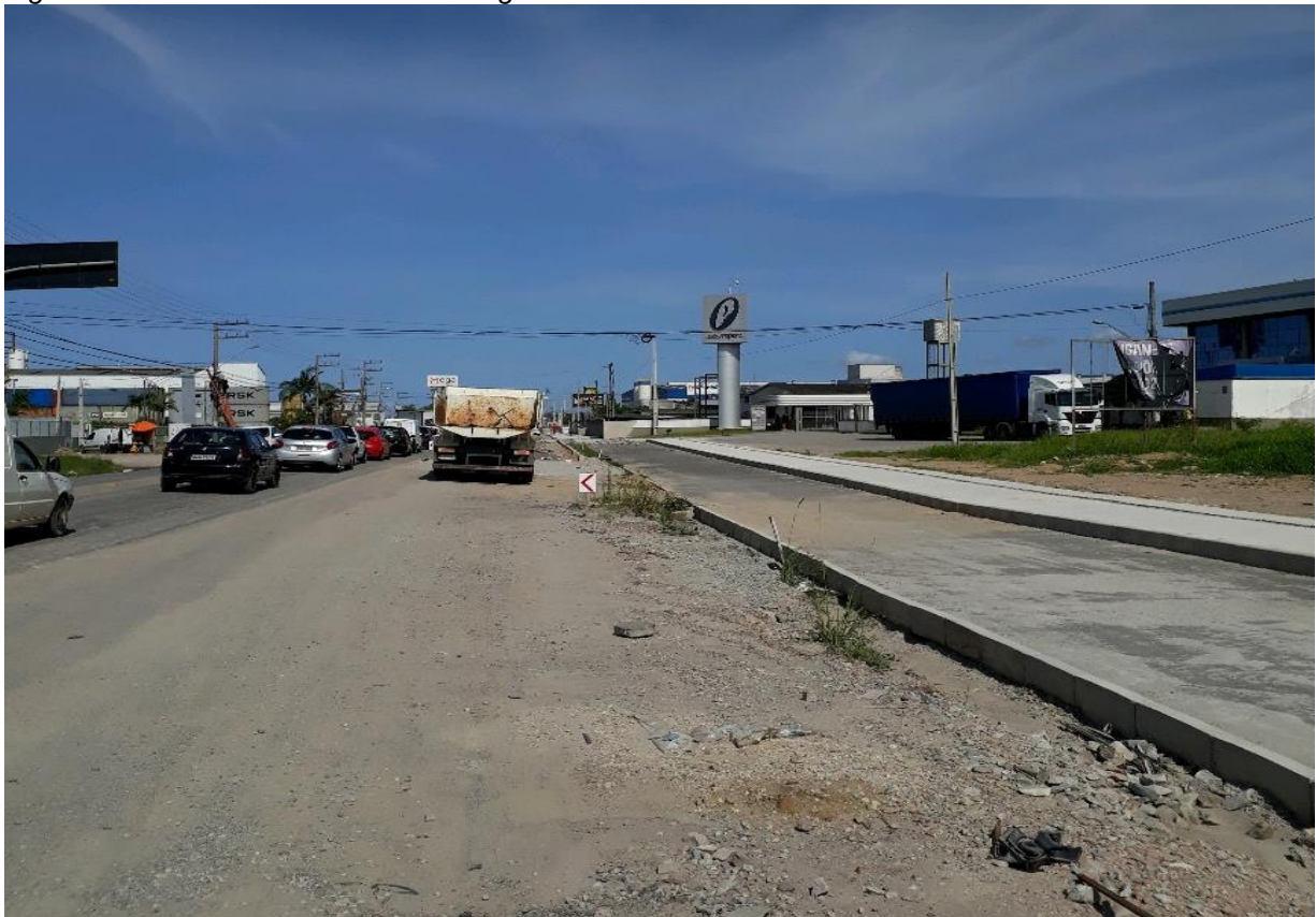
Figura 8: Obras na rodovia SC-412 Jorge Lacerda.
